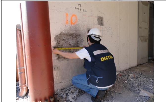
**Fotografía 24:** Vista del proceso de medición del espaciamiento de barras verticales en uno de los muros con remoción de recubrimiento.
