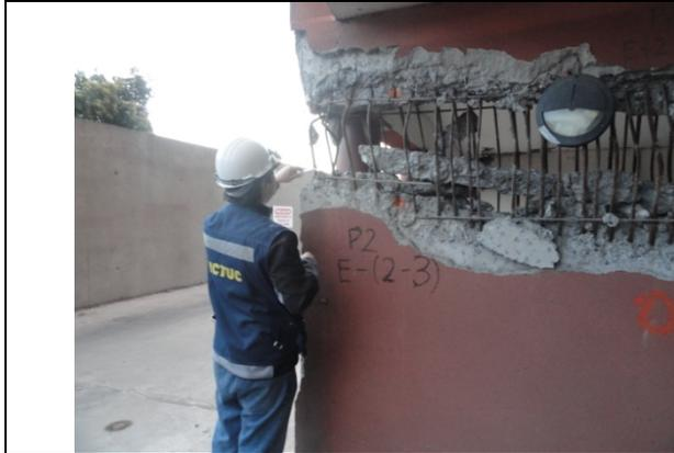
**Fotografía 26:** Detalle del proceso de medición de los diámetros de refuerzo con un pie de metro en la zona del borde del muro.
