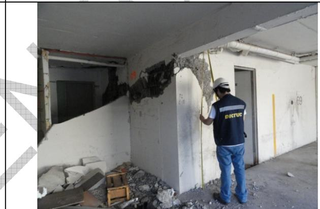
**Fotografía 29:** Detalle del proceso de medición elementos estructurales dañados.
