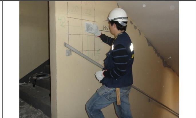
**Fotografía 10:** Preparación de la superficie mediante el uso de una piedra abrasiva.
