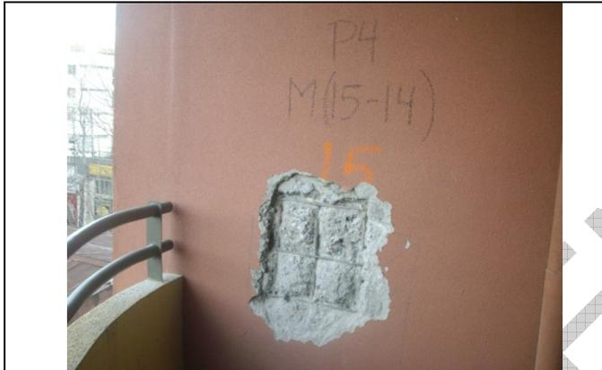
**Fotografía 22:** Vista de uno de los lugares una vez concluido el proceso de remoción de recubrimiento para la determinación de presencia de armadura en un muro del edificio en estudio.
