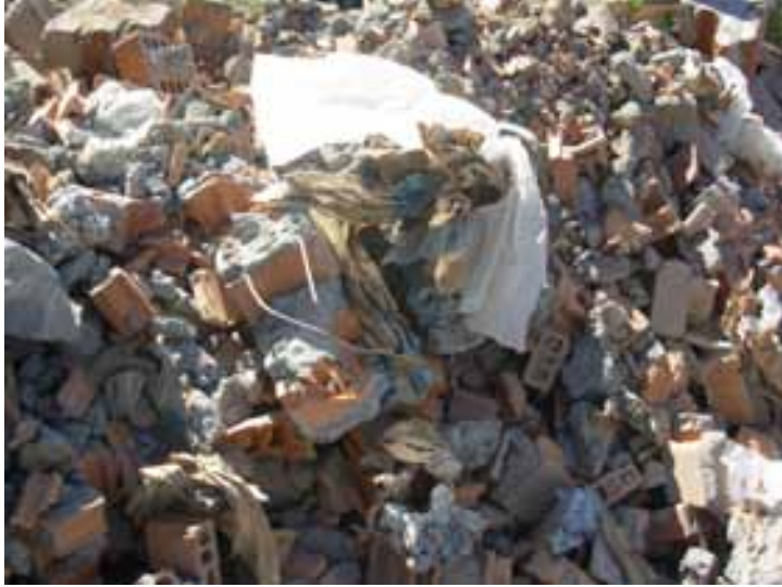
Figura 4: Detalle de escombros de muros cortafuegos. Nótese que los escombros contienen bolsas de cemento y plásticos.
