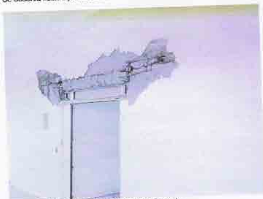
Fotografía N°4: Vista viga dintel acceso a gimnasio
