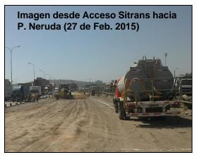
Pavimento Tramo Anibal Pinto - Av. La Playa. Está en ejecución las excavaciones para cámaras de aguas lluvias y excavaciones para ubicar redes
