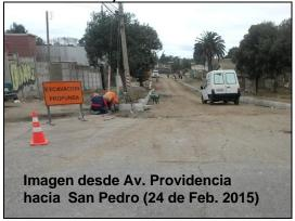
☐ Pavimento Tramo Av- Providencia – Mercedes. Se encuentra en ejecución la colocación de soleras (90%) y demolición de carpeta asfáltica existente (10%)
