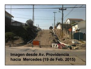
Pavimento Tramo Mercedes - Francisco Echaurren. Se encuentra en ejecución la colocación de soleras (95%) pero mayoritariamente rechazadas por problemas de alineación vertical y cancha para pavimentación de aceras (60%)
