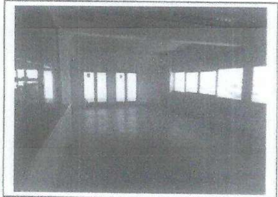
Vista Interior, Piso 7
