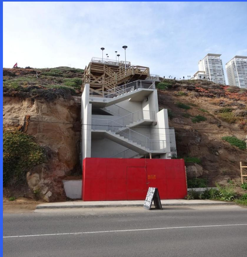
1° De madera: frágil, vulnerable, con deslizamientos, no cumple ancho de norma evacuación. A 521m
