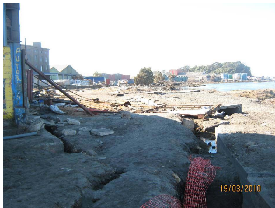
Colector 190, cajones dobles asentados y desbocados
