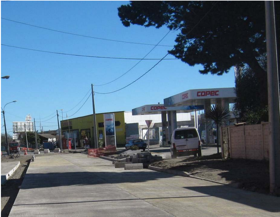
Recolocación de soleras dañadas Km. 2300 al Km. 2336
