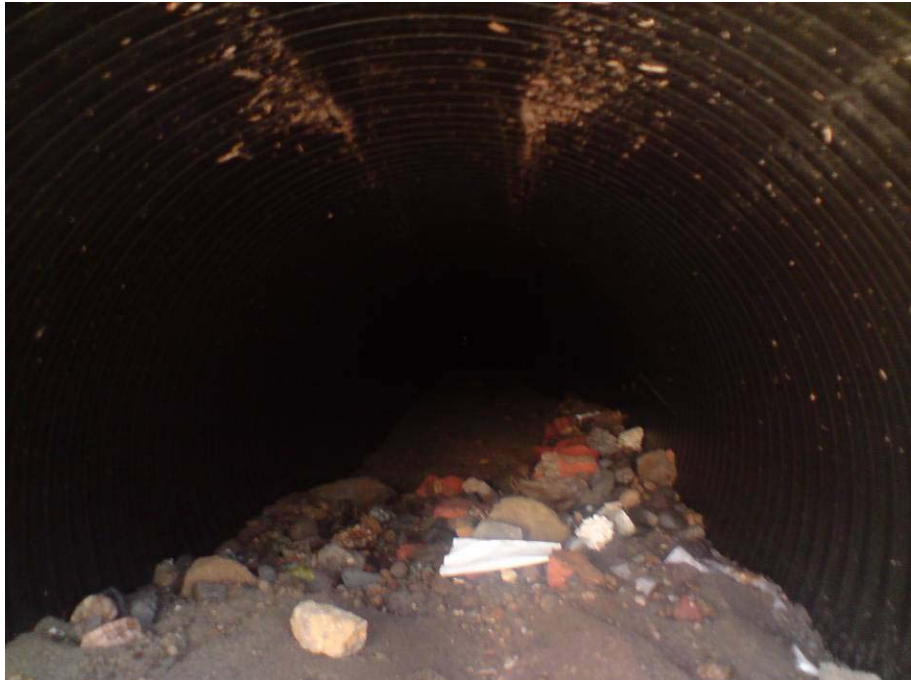
Embankamiento de colectores HDPE
