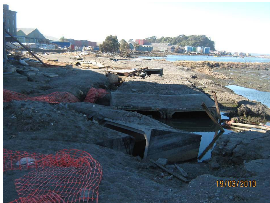
Colector 190, cajones dobles asentados y desbocados
